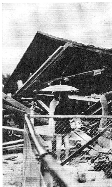
Une remise déplacée
